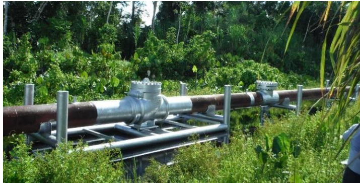
Figura 1 Progresiva km 177 del ORN, válvula check
