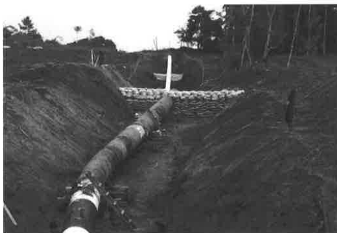
Gráfico N°1.32.- Ejemplo de ataguías a colocar entre el Km 323+140 al Km 323+240
