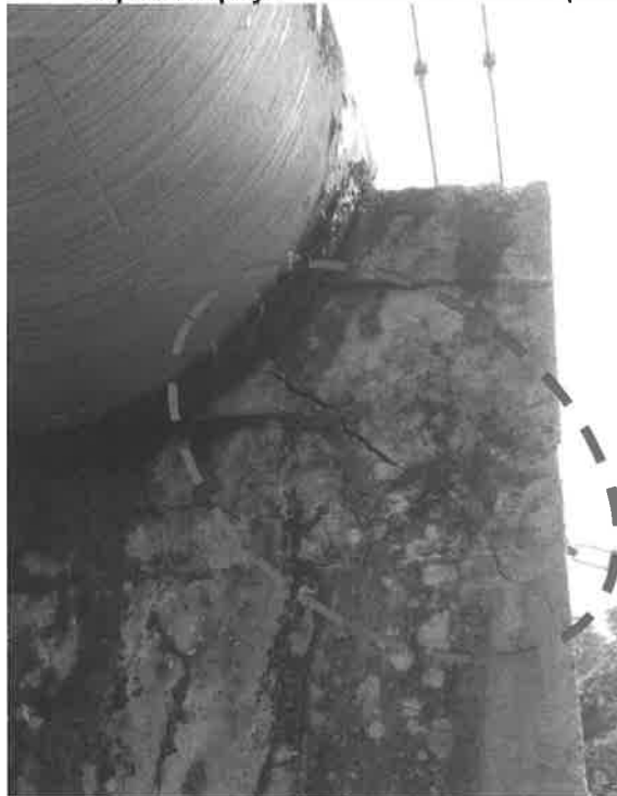
Gráfico N°1.13.- Se aprecia apoyo a reforzar en Torre 2 (lado Estación 6).
