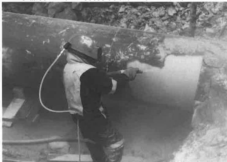
Gráfico N°1.31 Proceso de arenado a metal blanco
