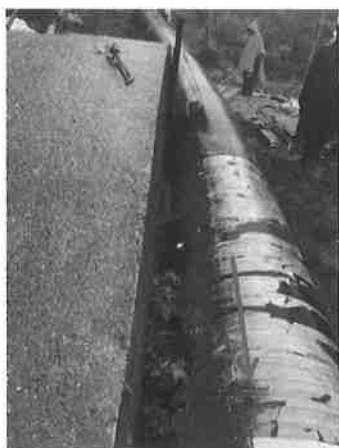
Gráfico N° 1.9.- Cercanía de tubería a bloque de anclaje y de tubería a cable de acero
