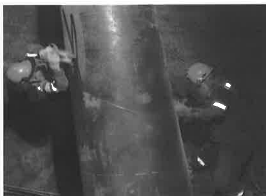
Gráfico N°1.34 Limpieza mecánica con esmeril, para inspección del ONP.
