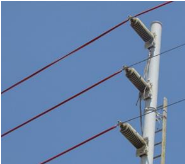
Instalación de cubiertas con equipo de fijación
