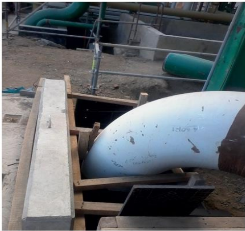
Box Culvert N° 02: Pendiente limpieza de acero, asegurar encofrado y vaciado de concreto.
