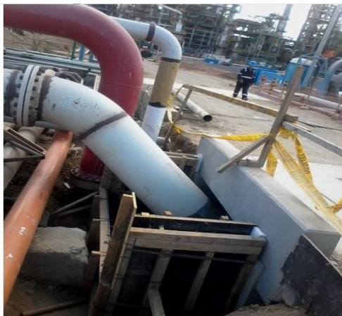
Box Culvert N° 03: Pendiente limpieza de acero, asegurar encofrado y vaciado de concreto.
