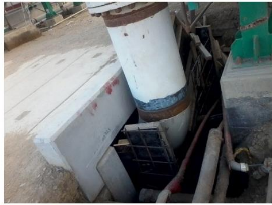
Box Culvert N° 01: Pendiente limpieza de acero, asegurar encofrado y vaciado de concreto.
