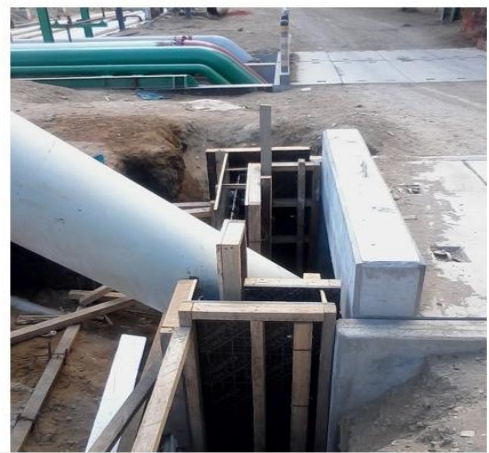
Box Culvert N° 02: Pendiente limpieza de acero, asegurar encofrado y vaciado de concreto.
