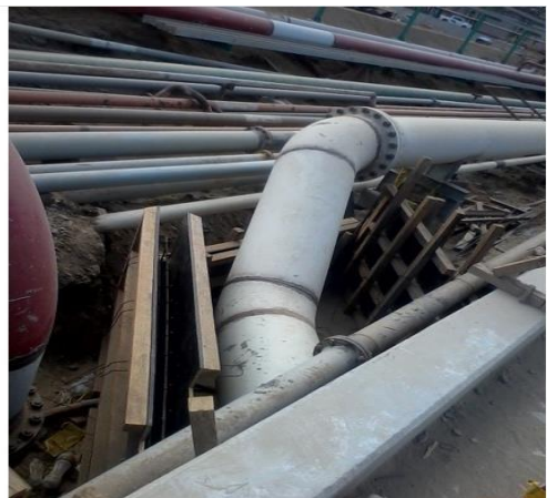
Box Culvert N° 03: Pendiente limpieza de acero, asegurar encofrado y vaciado de concreto.
