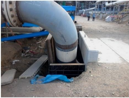
Box Culvert N° 01: Pendiente limpieza de acero, asegurar encofrado y vaciado de concreto.
