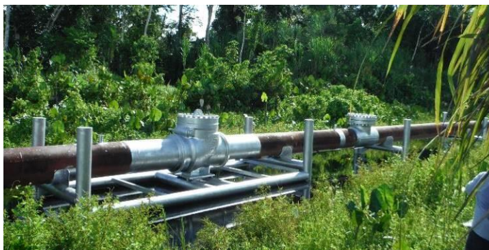
Figura 1 Progresiva km 177 del ORN, válvula check
