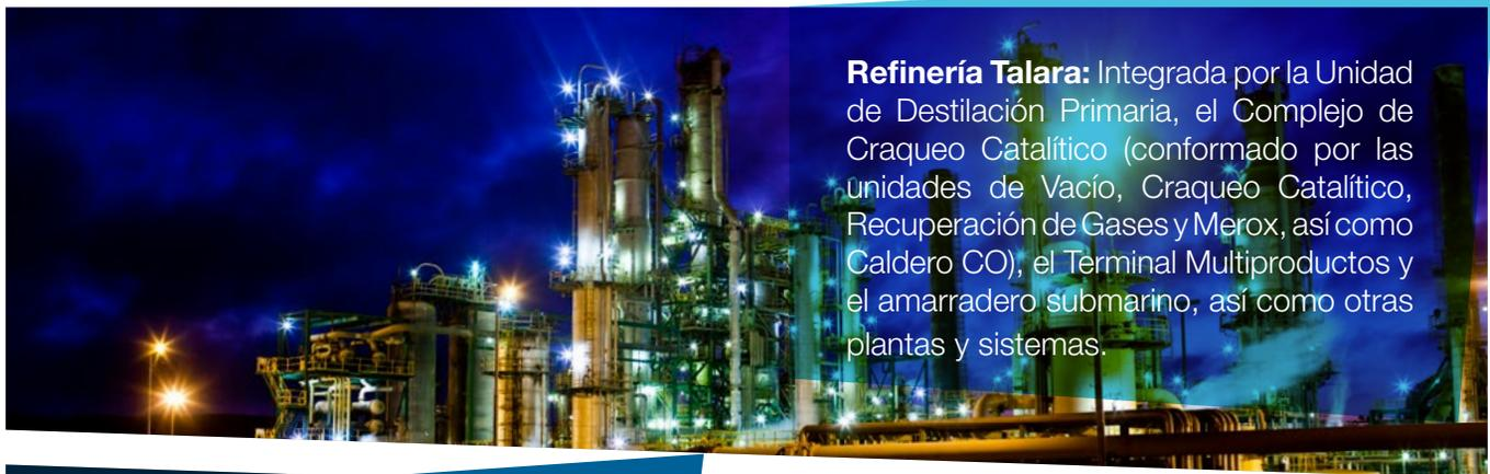
**Refinería Talara:** Integrada por la Unidad de Destilación Primaria, el Complejo de Craqueo Catalítico (conformado por las unidades de Vacío, Craqueo Catalítico, Recuperación de Gases y Merox, así como Caldero CO), el Terminal Multiproductos y el amarradero submarino, así como otras plantas y sistemas.
