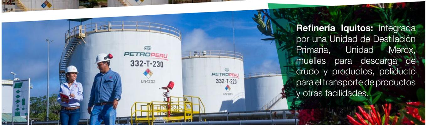
**Refinería Iquitos:** Integrada por una Unidad de Destilación Primaria, Unidad Merox, muelles para descarga de crudo y productos, poliducto para el transporte de productos y otras facilidades.
