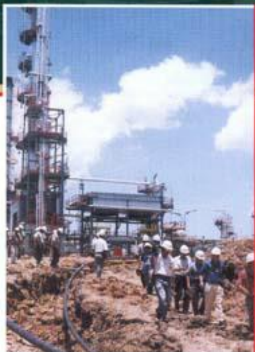
Construcción del Poliducto, Iquitos.
